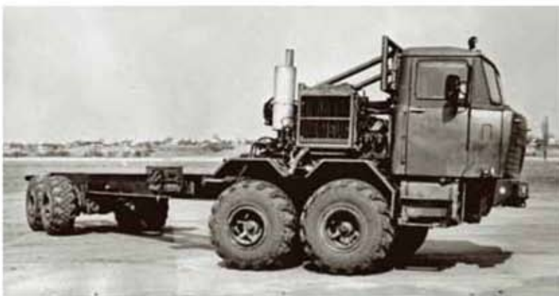
Обе секции КрАЗ-ЧР3120.02 получили по паре задних мостов, балансирующую подвеску и колеса от КрАЗ-260
